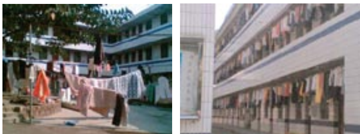
Een gebouw van 2 verdiepingen met slaapzalen (Bron: PlayFair)
